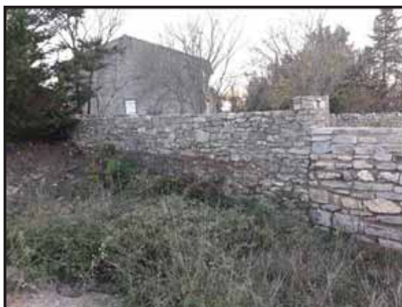
Vue du mur en pierre
