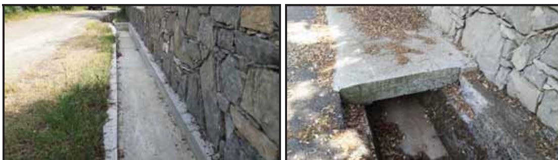
Vue d'un fossé et d'un ouvrage
