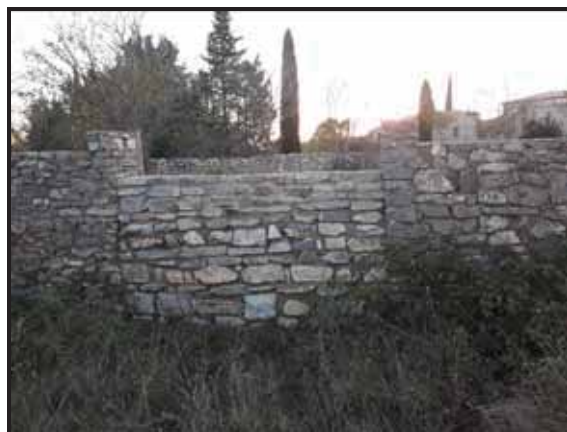
Vue de la partie reconstruite du mur en pierre
