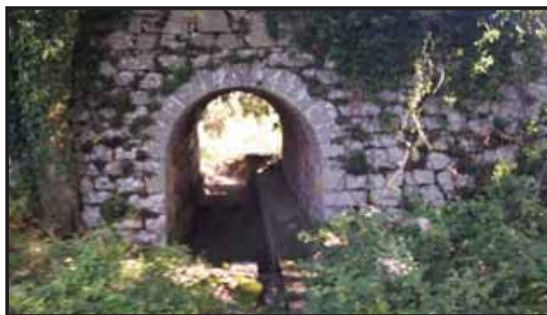
Vue de l'ouvrage Voûte
