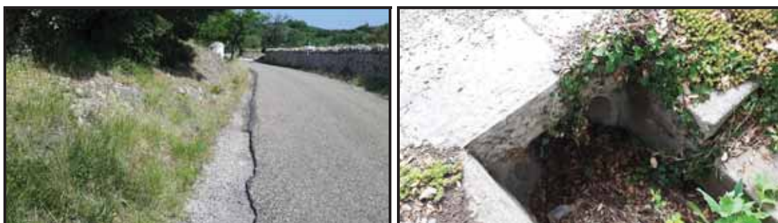
Vue d'un fossé et d'un ouvrage
