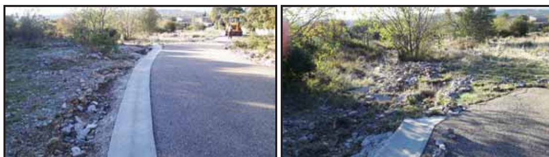
Vues de l'écoulement au droit du chemin de Tourrière
